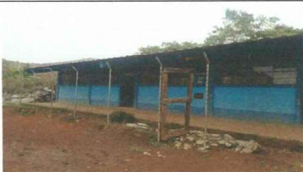
Foto 9: Sustitución de porton de madera a porton de metal.
