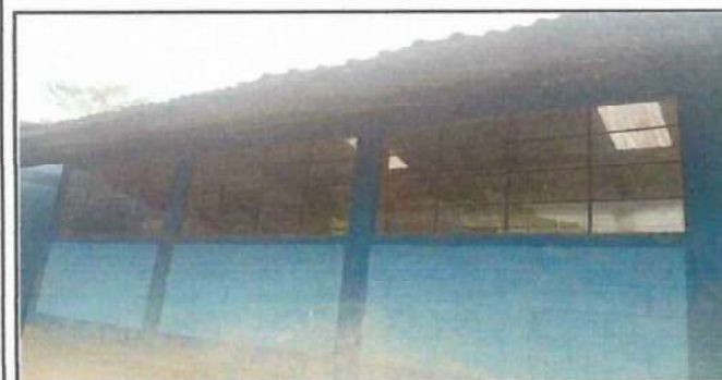
Foto 5: colocacion de balcones.
