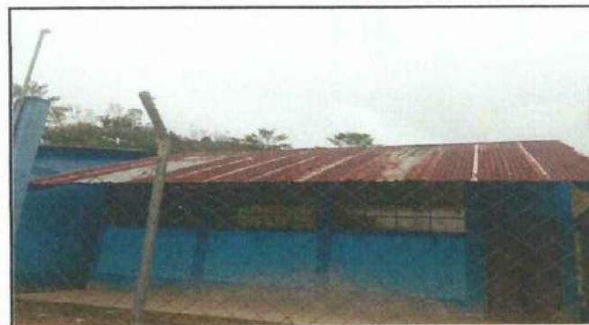
Foto 4: sustitución de techo del Establecimiento Unico modulo.
