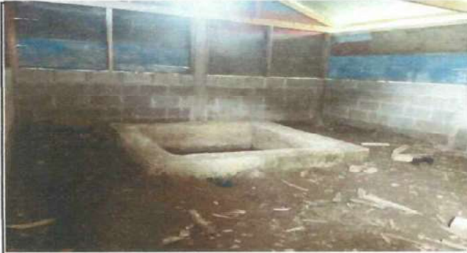
Foto 7: Ampliación de altura de la pila del Establecimiento.
