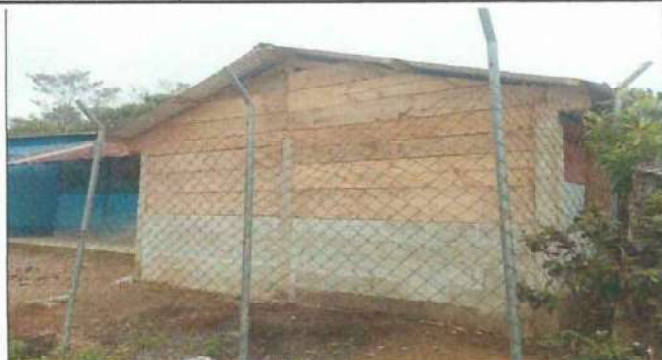
Foto1: Culminación de cocina, cambio de tablas de madera por block
