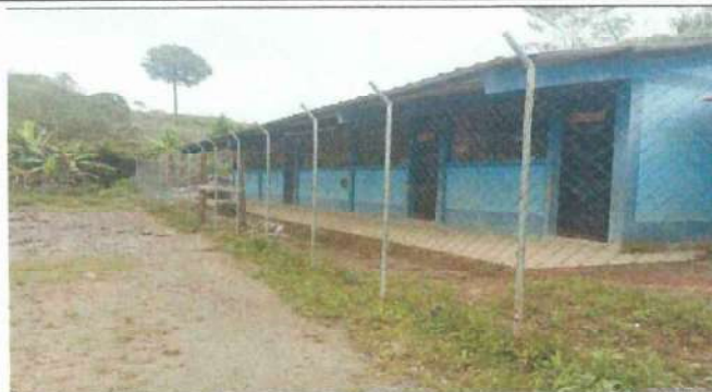
Foto 2: Mejoramiento del muro perimetral, sustitución de tubos galvanizados por concreto.
